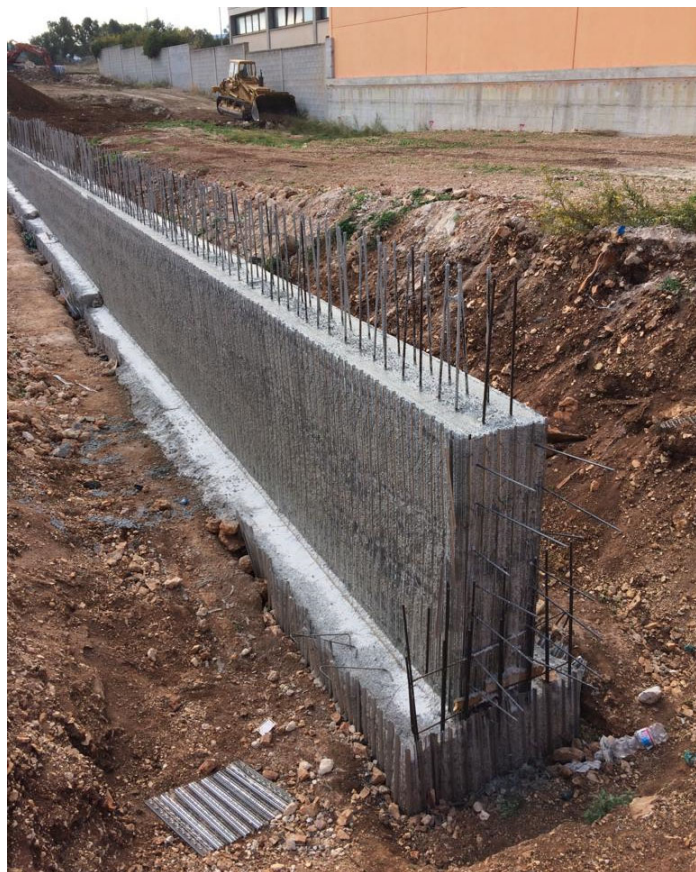
Figura n. 3 – Utilizzo di FERCASS® per travi rovesce di fondazione
