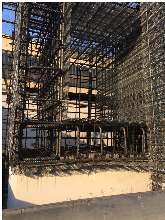
Figura n. 4 – Utilizzo di FERCASS® per elementi di fondazione
